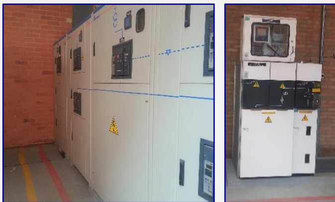
CONSTRUCCIÓN DE SUBESTACIONES
