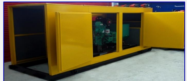
MONTAJE Y SUMINISTRO DE PLANTAS ELÉCTRICAS
