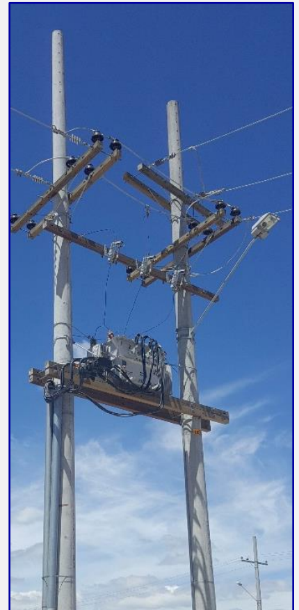
REDES ELÉCTRICAS Y MONTAJE DE TRANSFORMADORES
