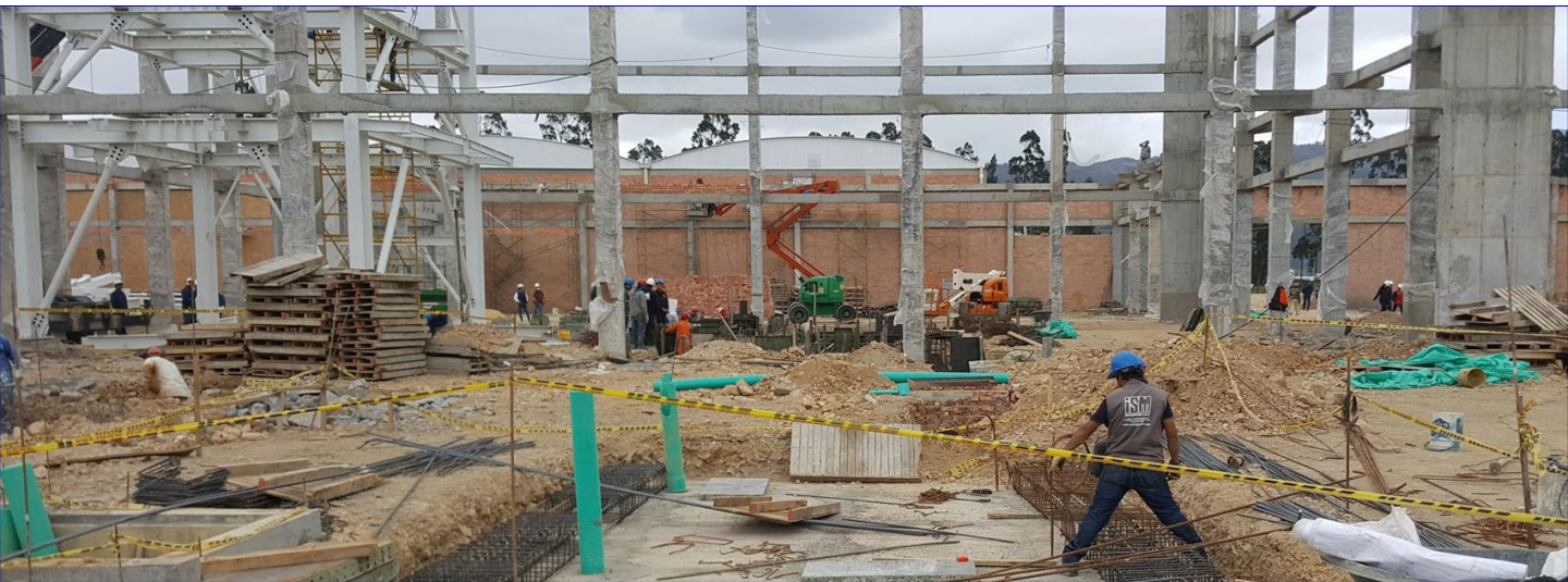
EJECUCIÓN DE OBRA CIVIL Y ARQUITECTÓNICA ASOCIADA AL PROYECTO ELÉCTRICO
