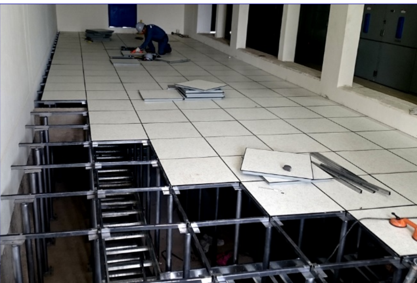
MONTAJE DE PISOS TÉCNICOS PARA DATA CENTER Y CUARTOS ELÉCTRICOS
